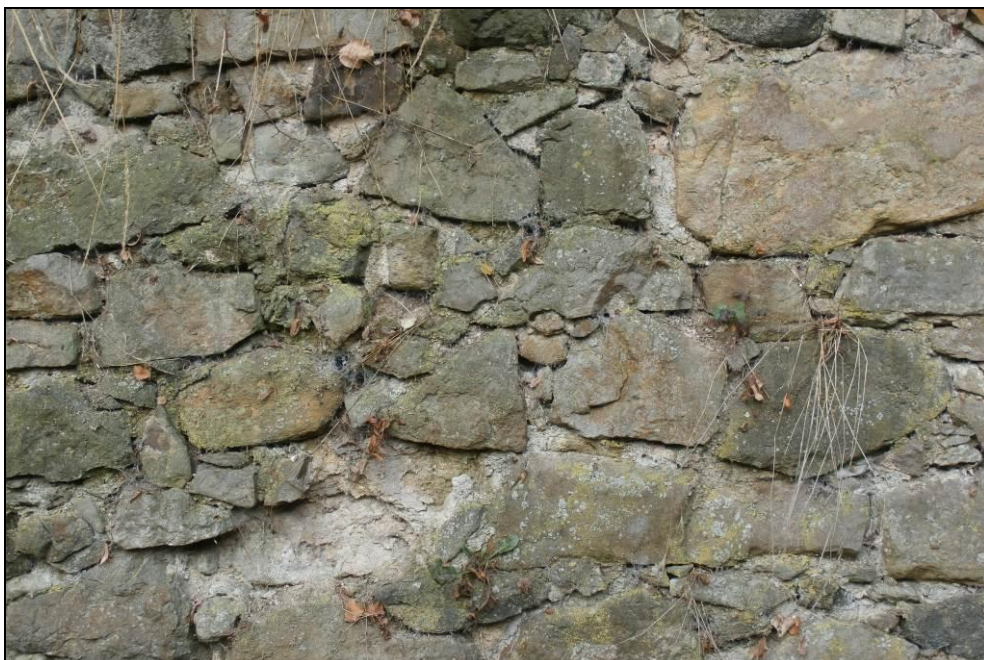
Obr. č. 11 - detail porušeného zdiva - pravá zeď koryta
