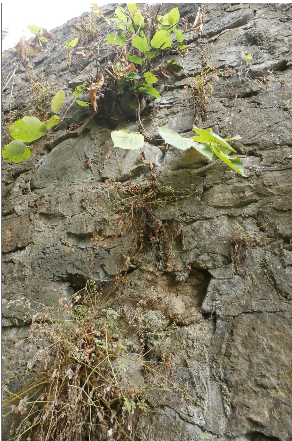
Obr. č. 12 - detail porušeného zdiva - levá zeď koryta
