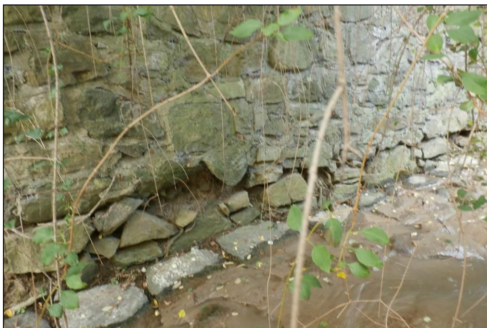
Obr. č. 8 - vyplavená spárová malta, která zapříčiňuje uvolňování jednotlivých kamenů ve spodní části zdi - pravá zeď koryta
