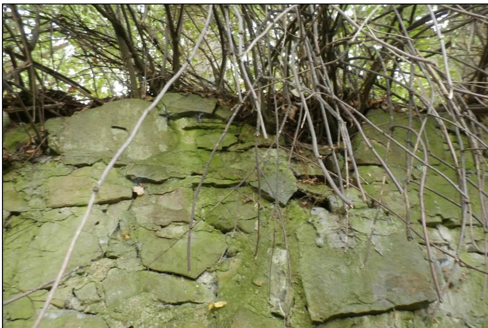
Obr. č. 10 - porušená koruna zdi od kořenů keře - pravá zeď koryta
